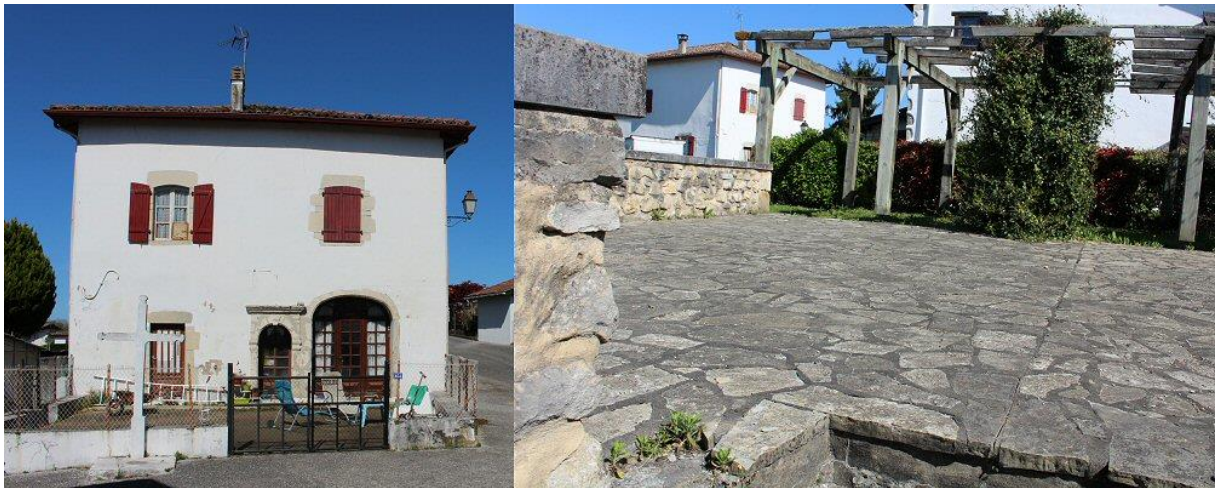
A gauche la maison Canton, à droite les vestiges de la maison Darrose
