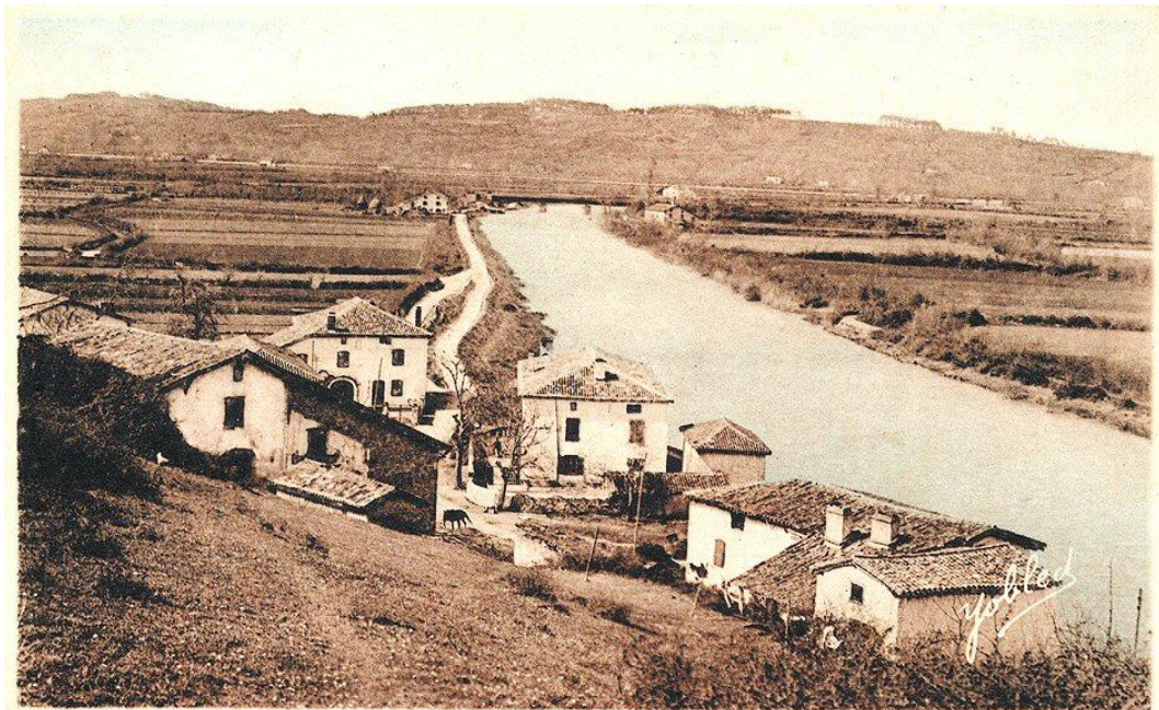
15. - GUICHE (B.-P.). — QUARTIER PORTES - LA BIDOUZE - PONT DU CHEMIN DE FER
